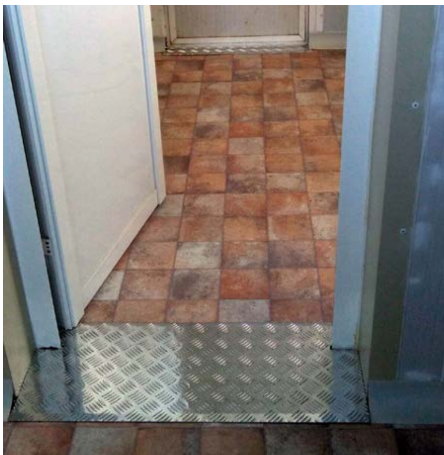
Fig. 3.3.08 ► Suelo de la sala de elaboración y sala de envasado y ventas.
