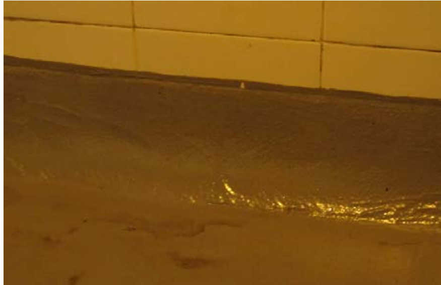
Fig. 3.1.09 ▶ Suelo epoxi con ángulo redondeado (realizado voluntariamente).
