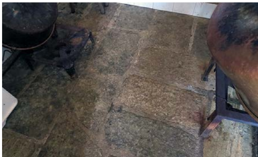
Fig. 31 ▶ Suelo de piedra en la sala de elaboración.
