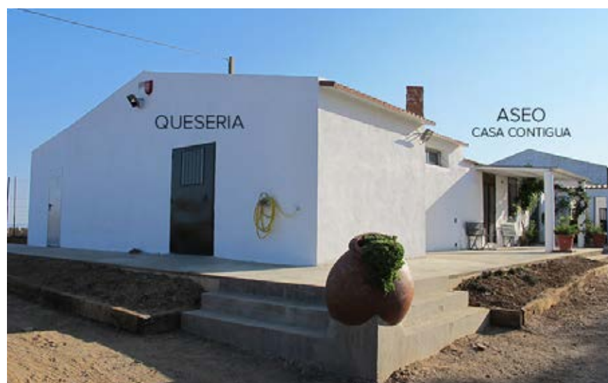
Fig. 12 ► Quesería artesana de campo que podría utilizar el aseo de la casa contigua.
