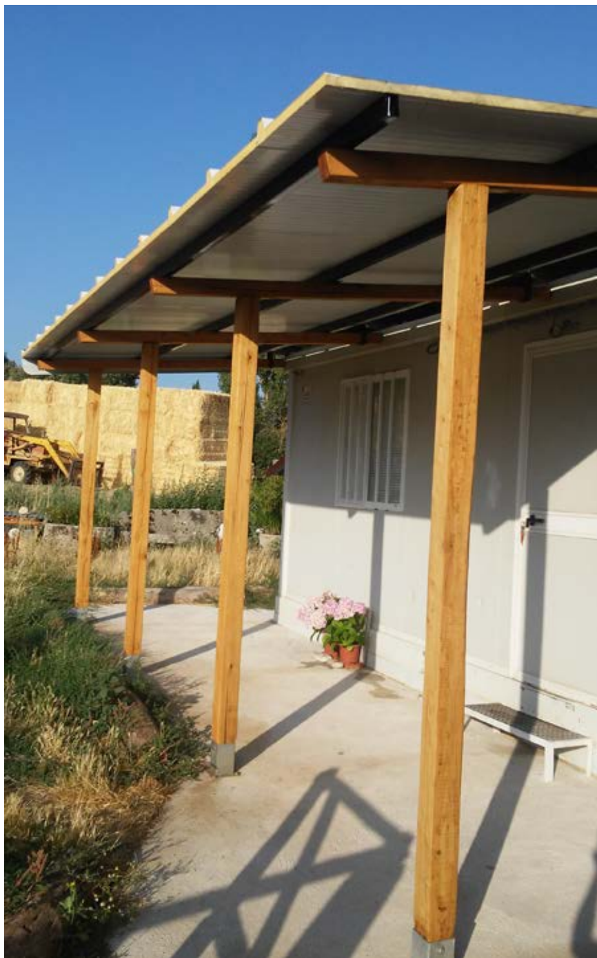
Fig. 3.3.01 ► Fachada de la quesería (en construcción).
