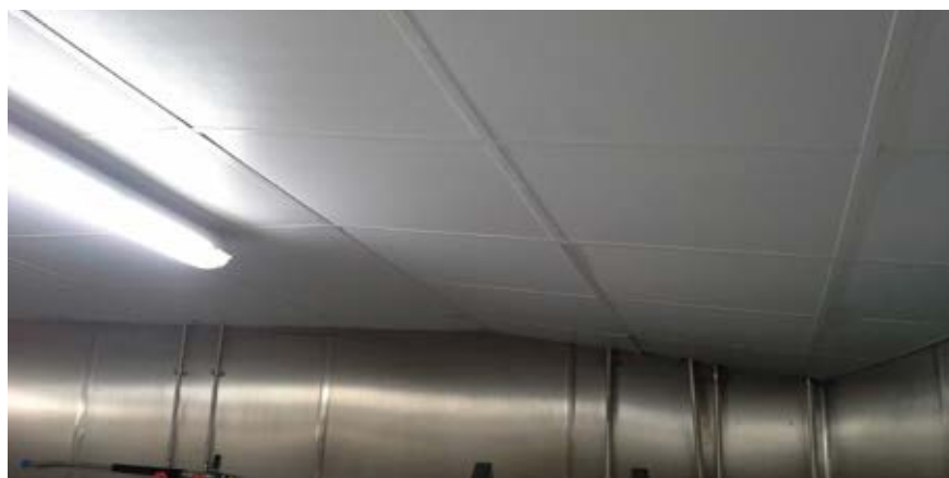
Fig. 3.2.10 ▶ Techo de paneles.
