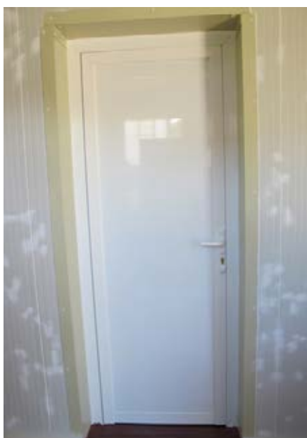
Fig. 3.3.11 ► Puerta de salida desde la sala de envasado y venta.
