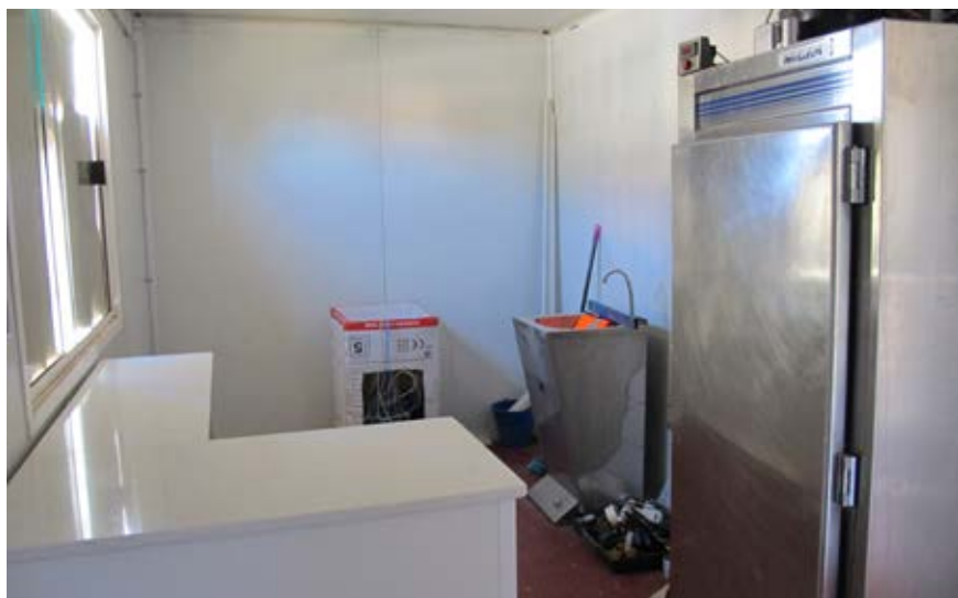
Fig. 3.3.04 ▶ Sala de envasado y ventas (sin finalizar los trabajos).
