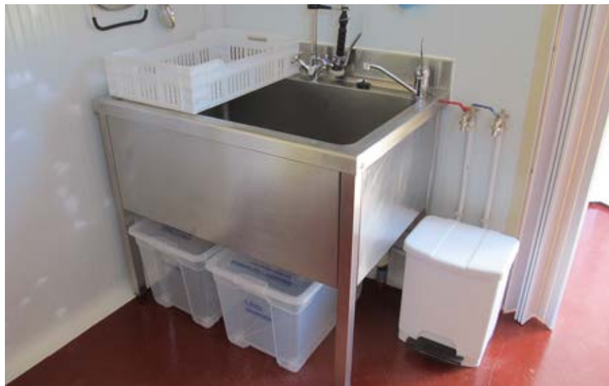
Fig. 3.3.05 ► Fregadero multiuso en la sala de elaboración. Doble grifo para gran y pequeño material y lavado de manos (voluntario).
