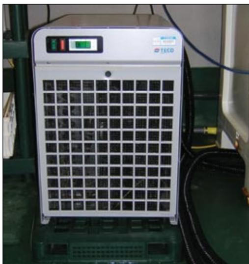
**Figura 5.10:** Unidad mixta de calefacción y refrigeración para uso en un sistema de pequeña escala de diseño estándar
