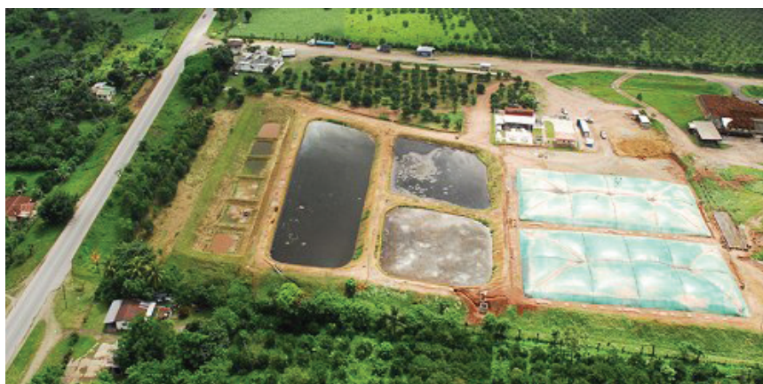
Figura 8. Sistemas de depuración biológica por oxidación
