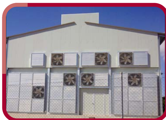
Cabecera de nave con sistema de ventilación tipo túnel
