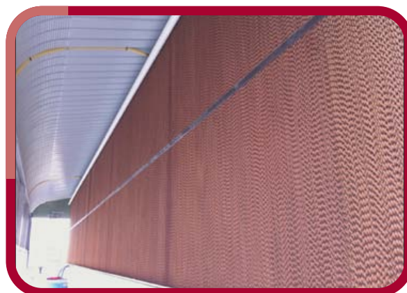
Paneles de refrigeración.
