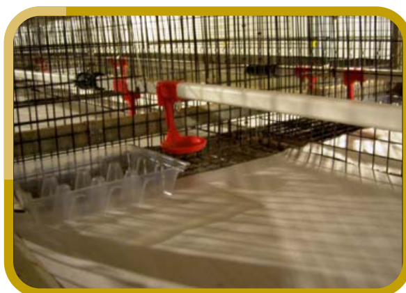
La nave y equipos deben estar perfectamente limpios y desinfectados antes de la entrada de las pollitas.
