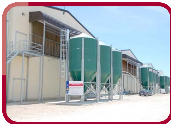
Cabeceras de nave con los silos de pienso y sistema de ventilación con paneles
