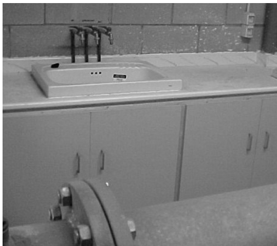
FIGURA 20. Pila para la toma de muestras en una planta de tratamiento (Aigües del Prat, SA).
