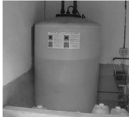
FIGURA 15. Depósito de hipoclorito (Aigües del Prat, SA).
